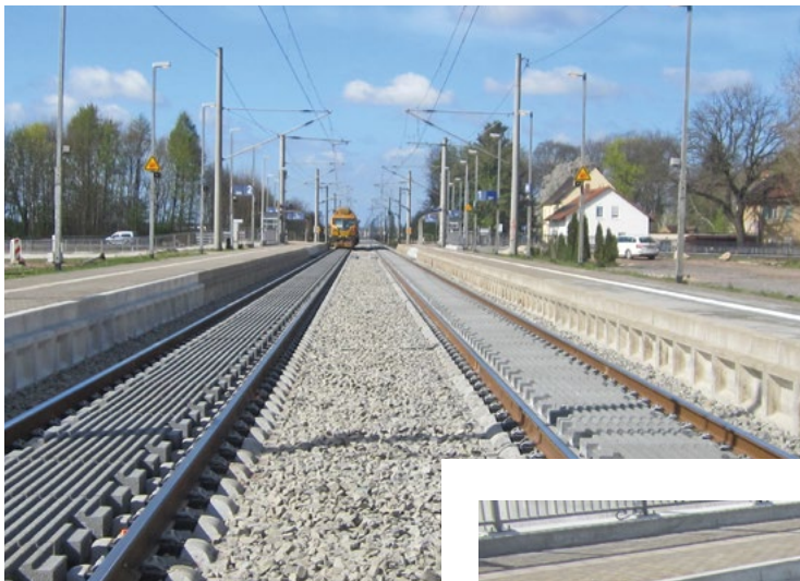
Nach einem „heissen Winter“ verkehren die Bahnen jetzt auf Fester Fahrbahn.
