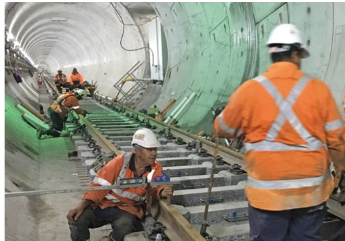
... vom Einbau der Festen Fahrbahn im längsten Eisenbahntunnel Australiens.
