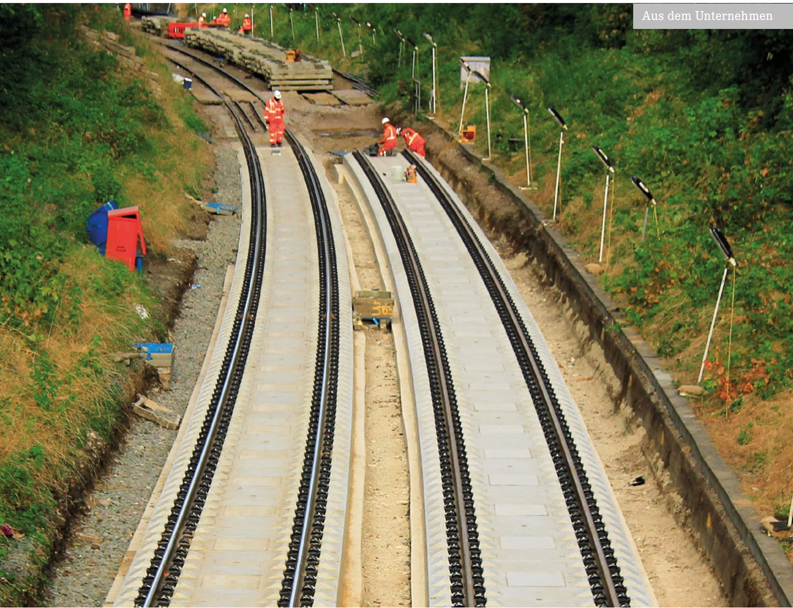
FF zum Vierten: Einbau der Festen Fahrbahn in Gospel Oak.
