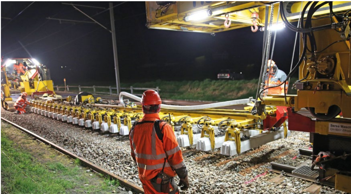
Eine der Aufgaben beim maschinellen Gleisbau: Legen der Betonschwellen, auf denen die neuen Schienen dann verschraubt werden.
