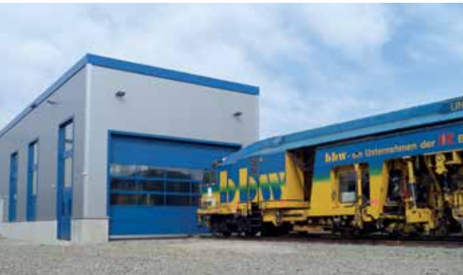
„Zuwachs“ auf dem Firmengelände der Bahnba Wels: Die neue Halle steht für Wartungsarbeiten und Winterreparaturen zur Verfügung.
