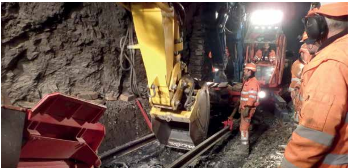
Gleisabsenkung mit Meterspur-Spezialmaschine TYREX.
