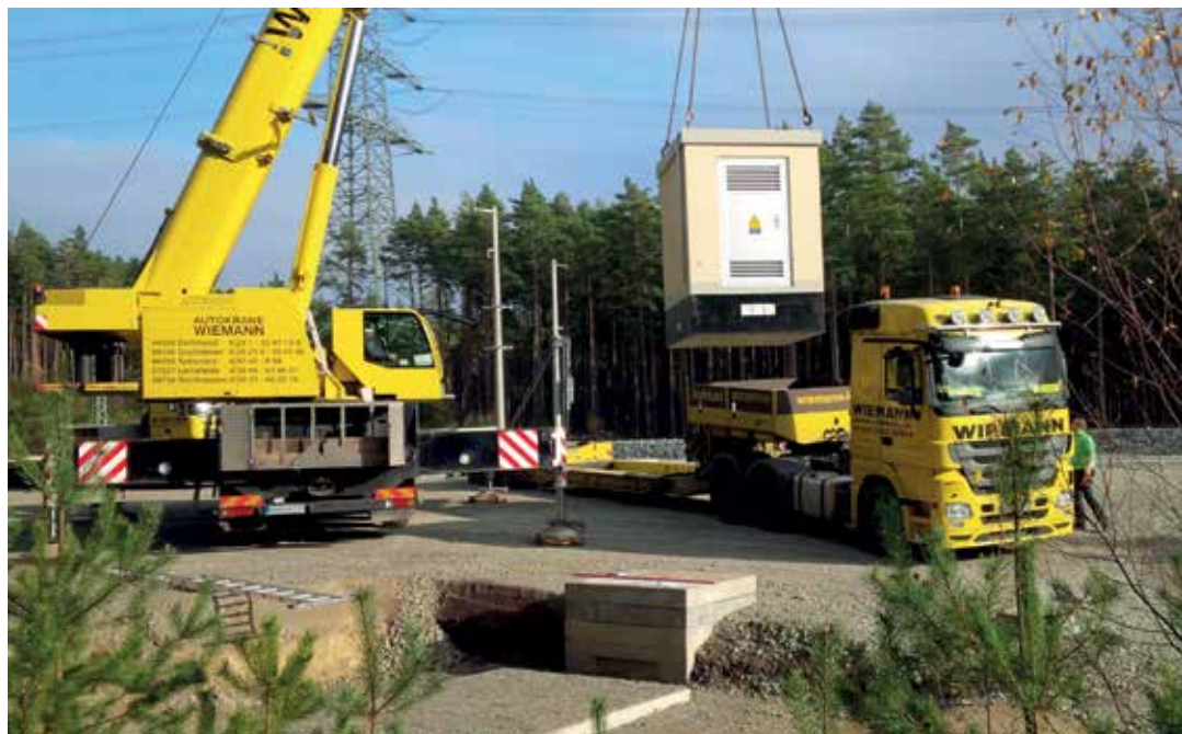
Ein Autokran verlädt eines der unzähligen Transformatorhäuschens zwischen Ebensfeld und Erfurt.
