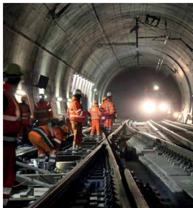
Arbeiter beim Einrichten einer Weiche.
