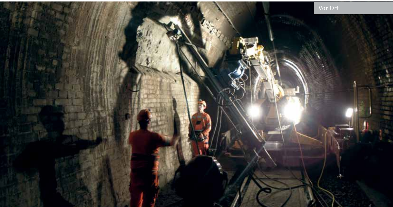
Herstellung einer Riegelankerung 60°, Mittelsektion (Muffennische 2, Simplontunnel IIb).
