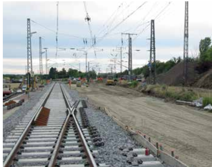
Aus alt mach neu: Insgesamt neun 500er-Weichen sowie eine Kreuzung mussten grunderneuert werden.
