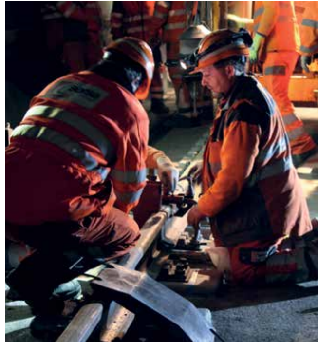
Arbeitsvorbereitung zum Schienenschweissen.
