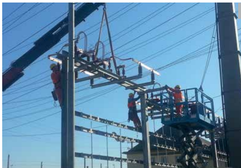
Montage eines Schaltgerüsts im Bahnhof Amstetten, Österreich.
