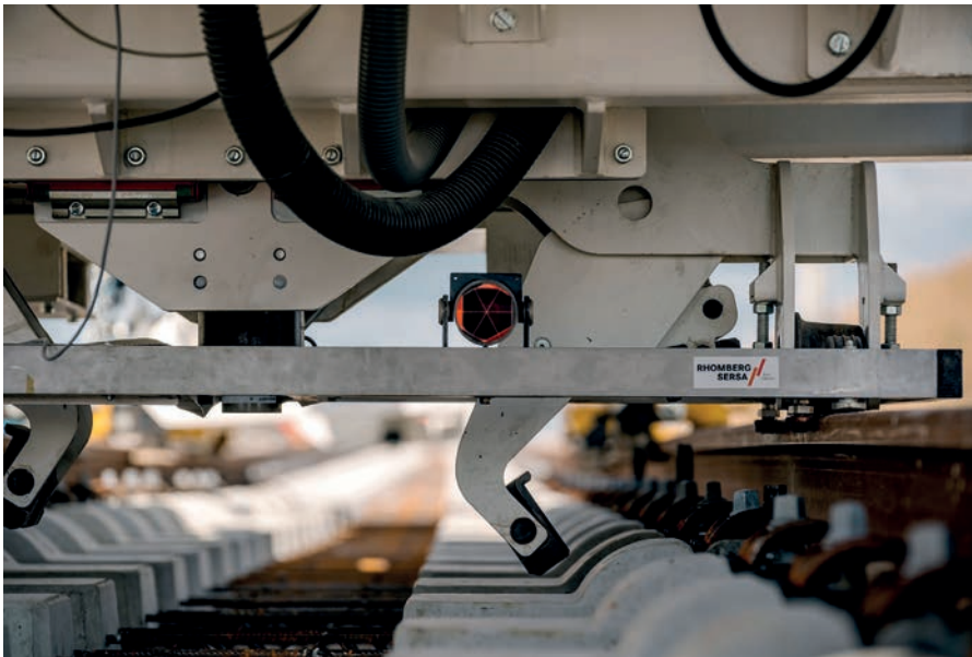
■ Bild 8: Gleismesswagen mit Prisma unter RS RhoMAT
