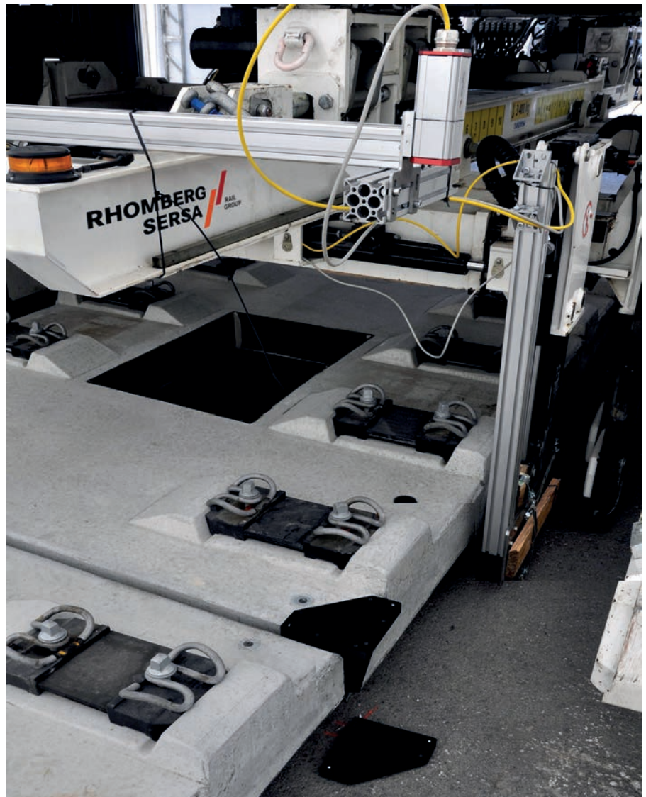
Bild 3: Kameragestützte Ablage von Gleistragplatten
