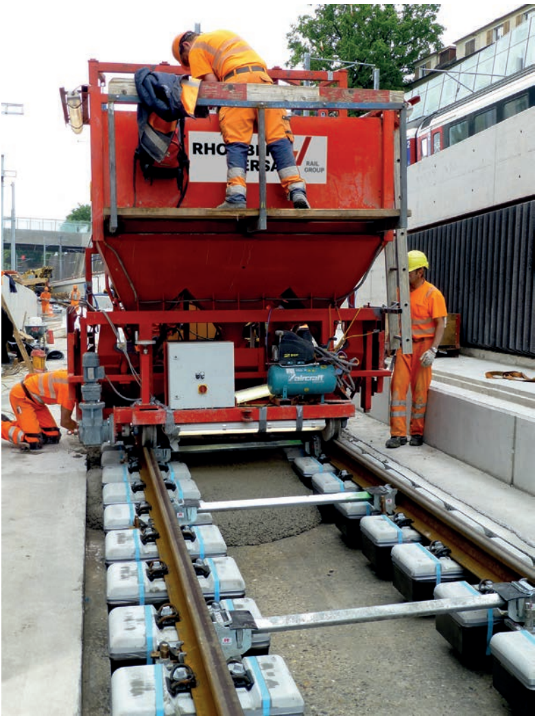
Bild 6: Betonfertiger auf RS RhoFAS fixierten Schienen
