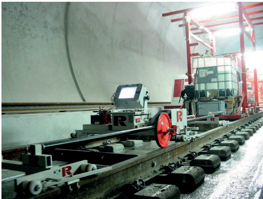
■ Bild 11: Mechanische Sehne gekoppelt mit Betonfertiger
