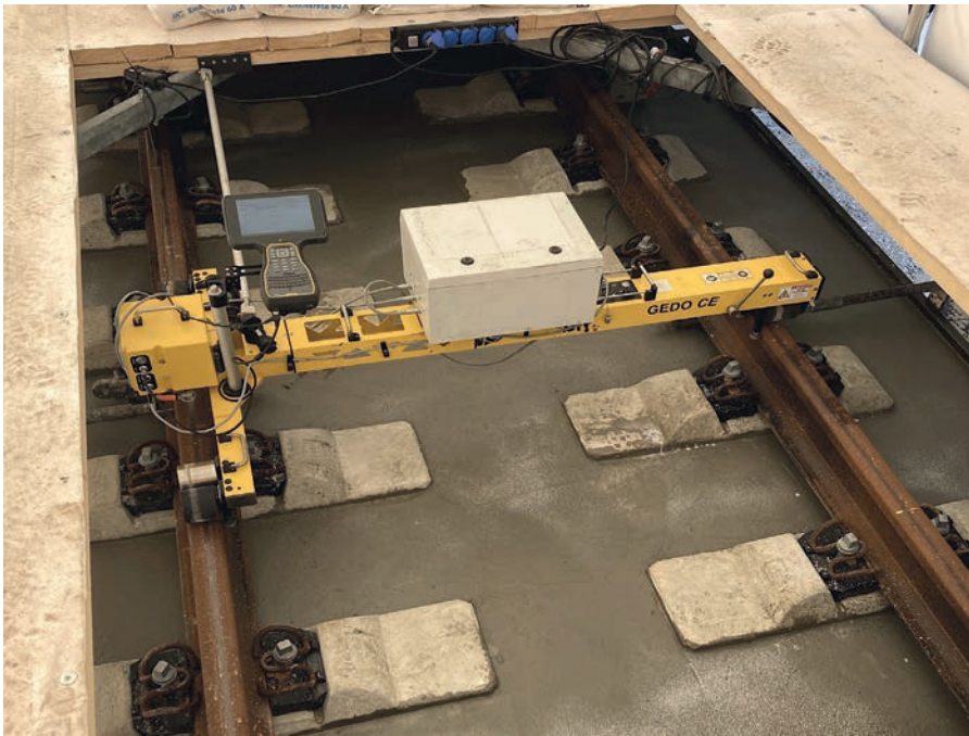
Bild 12: Gleismesswagen gekoppelt mit Betonfertiger
