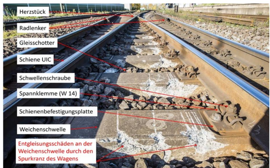
Abb. 3: Draufsicht auf eine Betonschwellenweiche mit Abplatzungen
