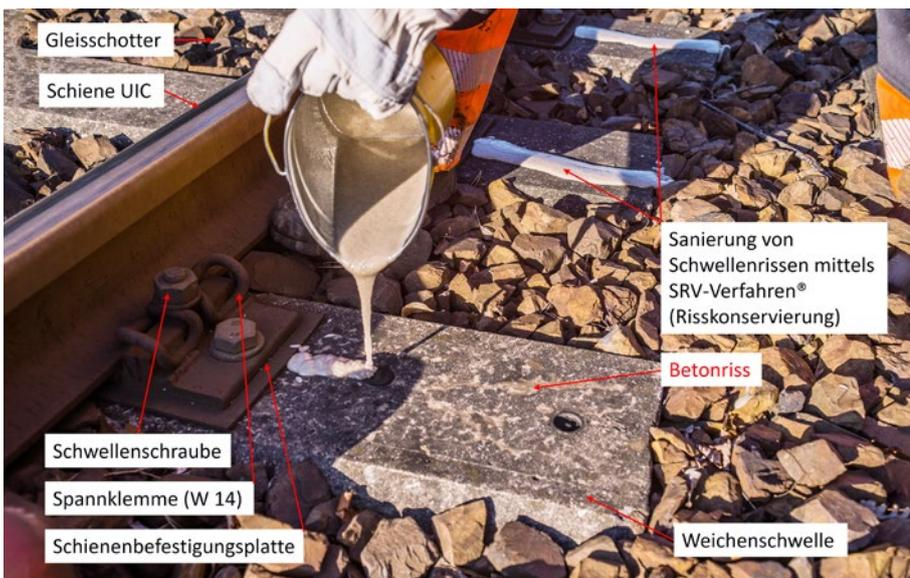
Abb. 5: Händischer Verguss eines Dübelrisses
