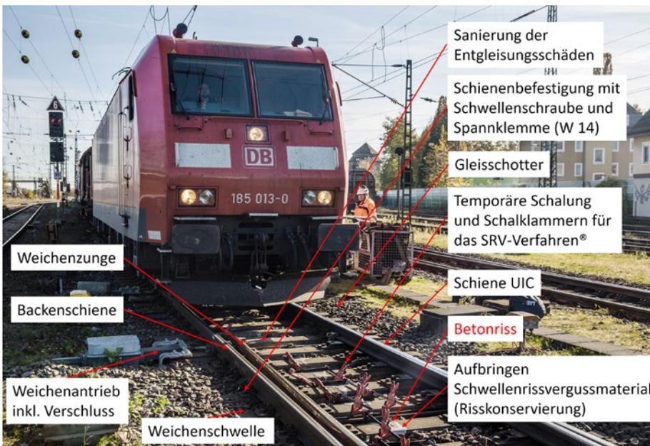
Abb. 4: Sanierungsarbeiten mit dem SRV-Verfahren unter dem „Rollenden Rad“
