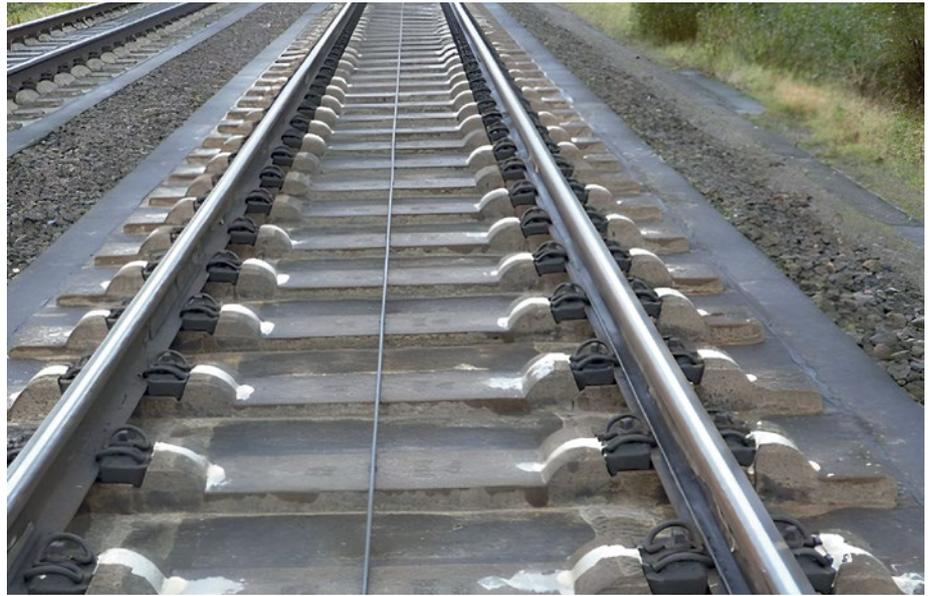
Abb. 8: Sanierte Schwellen in FF
