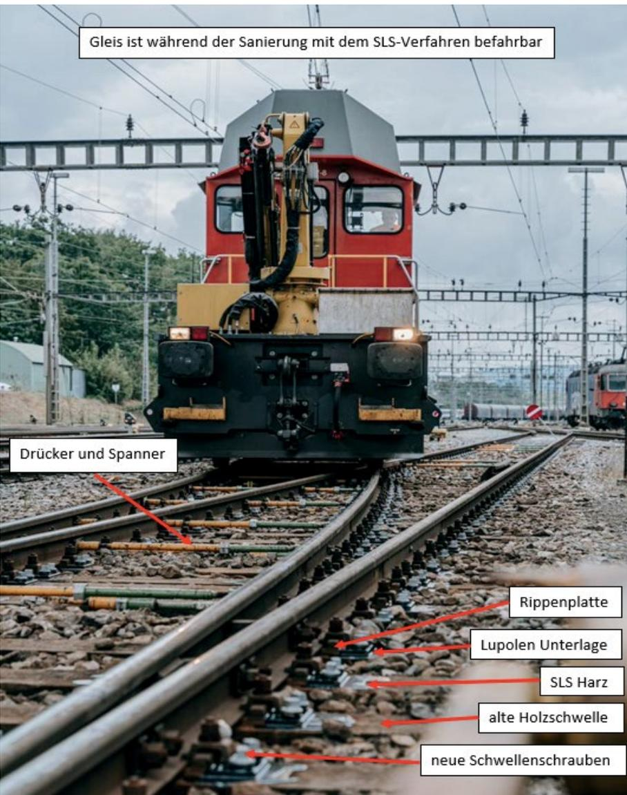
Abb. 5: Wechselseitiger Einbau von isolierten Drückern und Spannern bei der DB AG
