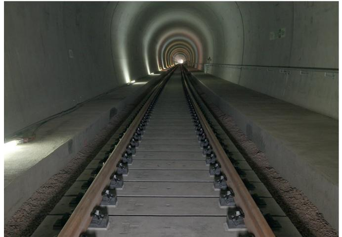
Abb. 4: Fertiggestelltes FF-System IVES im Zierenbergtunnel
