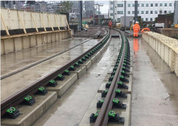
Abb. 3: Fertiggestelltes IVES-Gleis bei der Network Rail in Manchester
