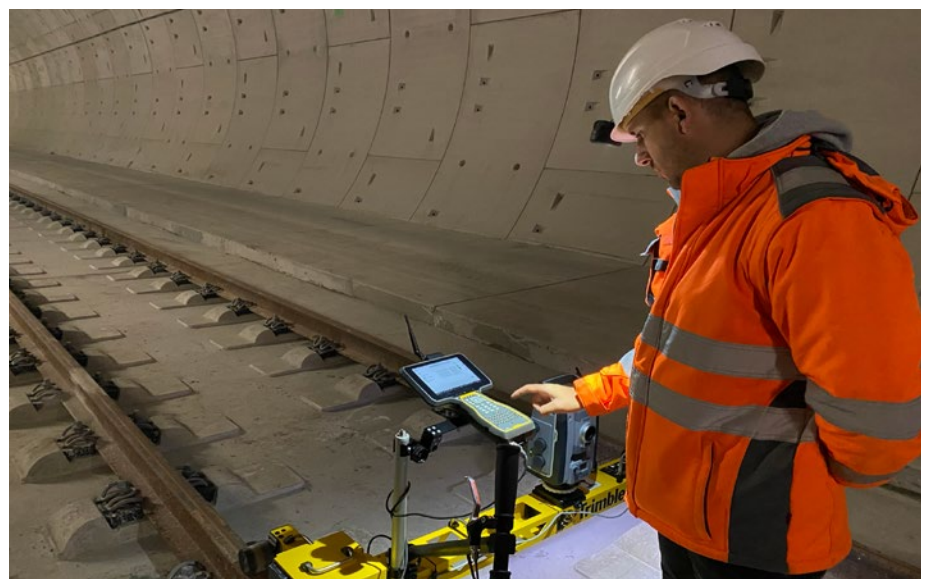
Abb. 4: Gleismesswagen GEDO IMS mit IMU, Totalstation und Feldcomputer an einer Stop-Position (Messung der aktuellen absoluten 3D-Lage)
