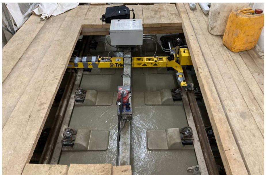
Abb. 1: Mit dem Betonfertiger gekoppelter Gleismesswagen mit IMU, Stromversorgung und Feldcomputer
