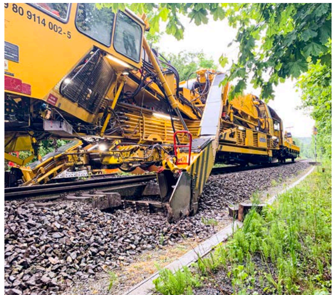
Bettungsreinigungsmaschine RM 80-92 UHR im Einsatz in Deggendorf-Ulrichsberg (Fa. JumboTec)
