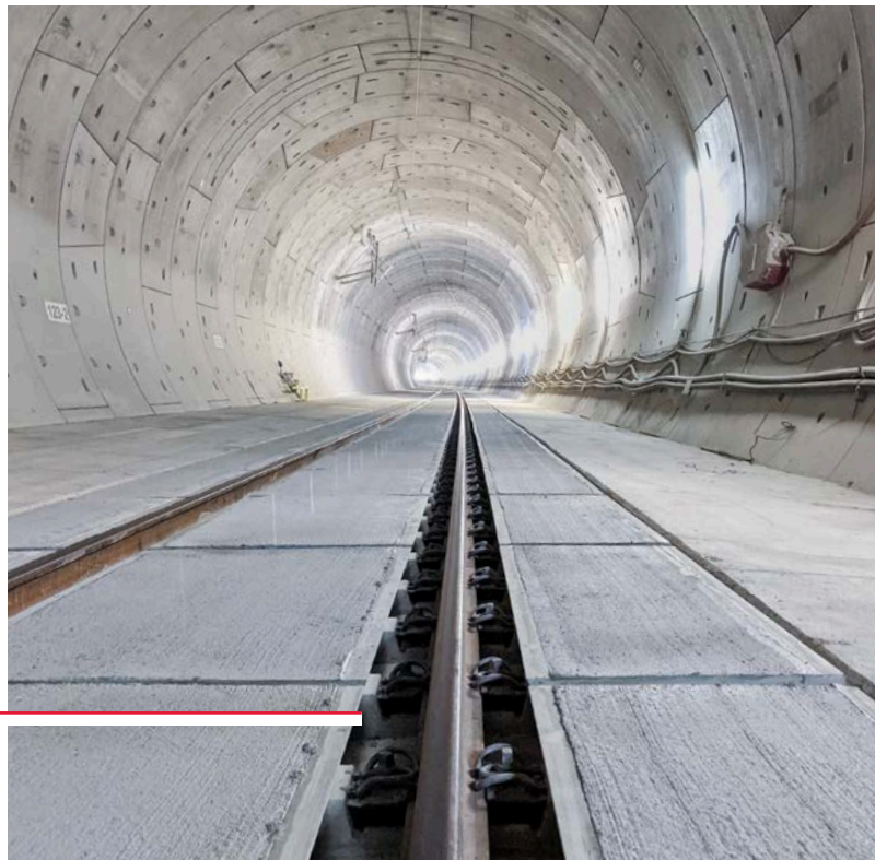
Die eigens entwickelte Gleiseindeckung für Feste-Fahrbahn-Systeme ermöglicht die Zufahrt für Strassenfahrzeuge.
