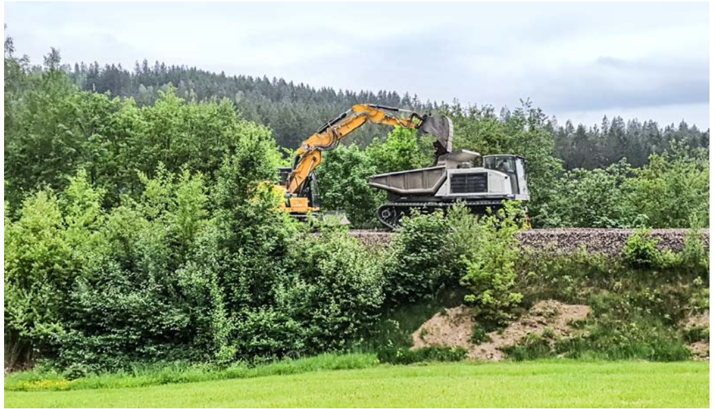
Ausbau des Schotters mittels Kettenbagger und Kettendumper beim Bauvorhaben in Zwiesel
