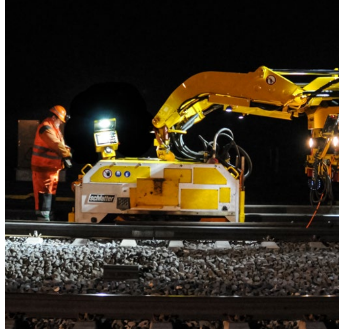
■ Abbrennstumpfschweißen mit SERSTAR
