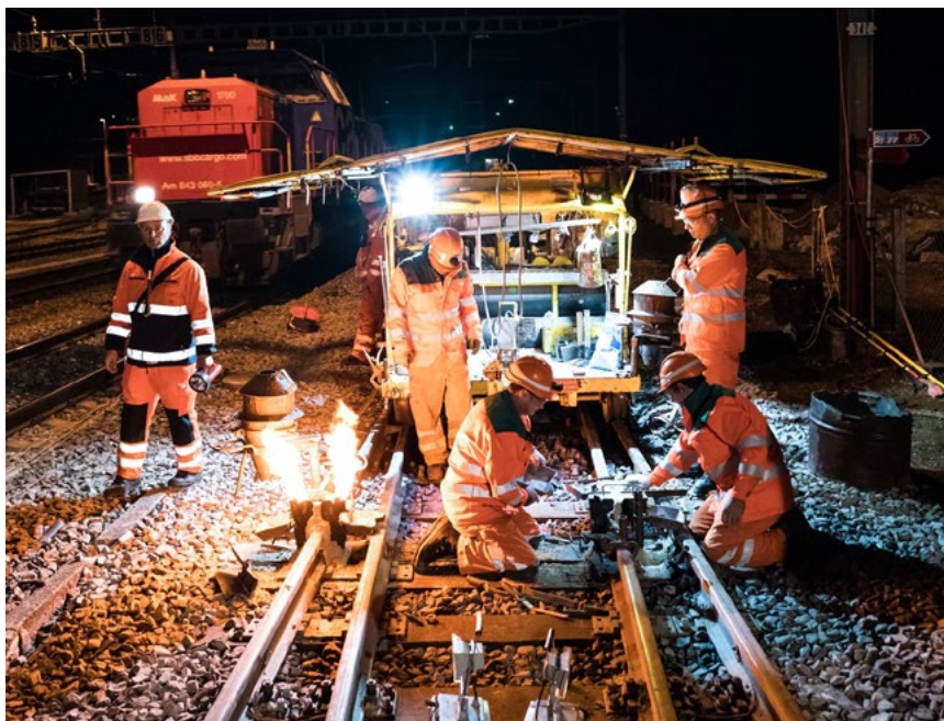
■ Aluminothermische Schweißungen in der Weiche
