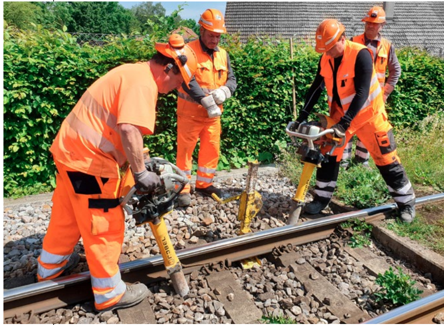
Einzelfehlerbehebung in Auzeig
