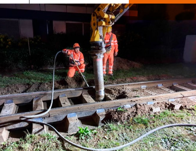
■ Freilegen der Gleistragplatte in der Eigentrasse (Schotterrasen)
