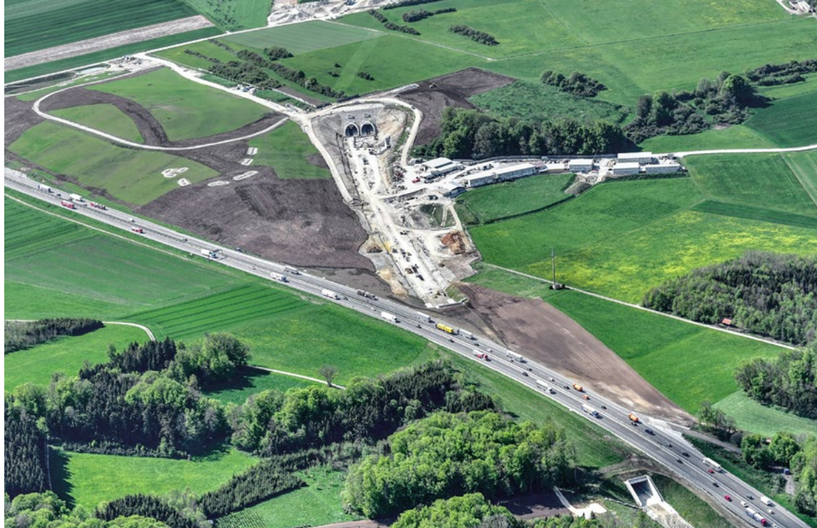
■ Das Baubüro der ARGE am Ostportal des Steinbühltunnels
